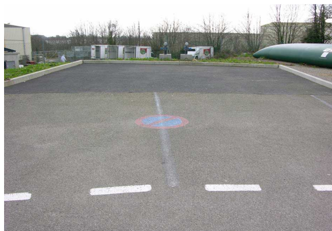
Plate forme d'aspiration sur une réserve d'eau équipée de deux colonnes d'aspiration de 100 mm
